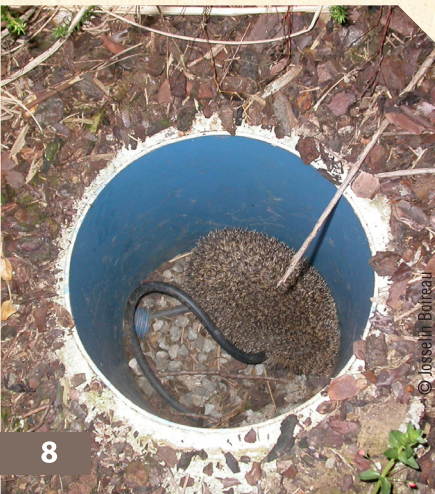
Hérisson tombé dans une installation électrique.
